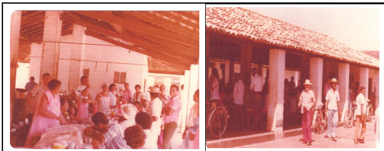
Figura 23 – Mercado Público (primeiras instalações). Fonte: Arquivo Particular da Profª. Livramento Lima.
